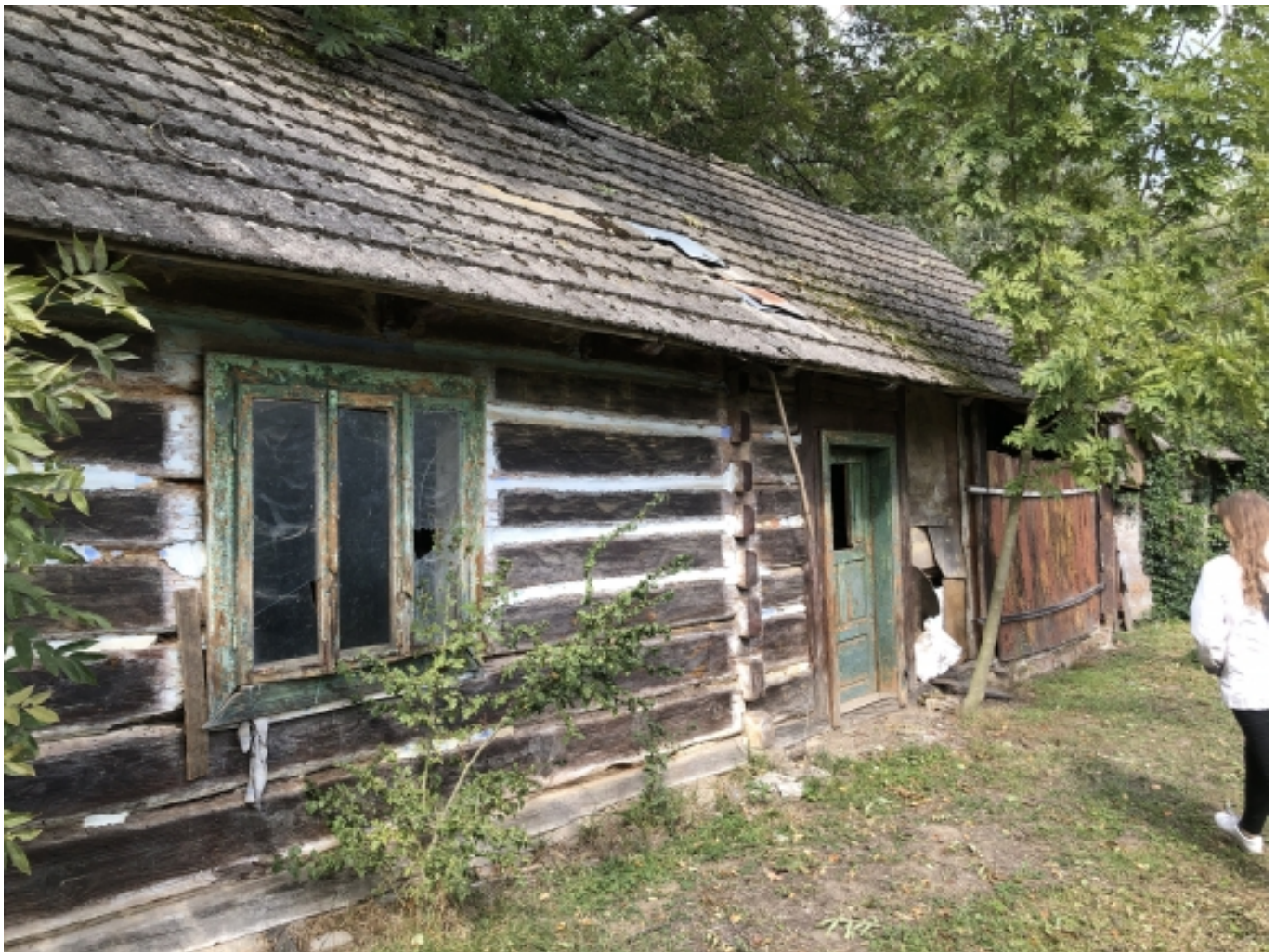
Zdjęcie domu przygotowywanego do rozbioru Fot. Zuzanna Deptuła
